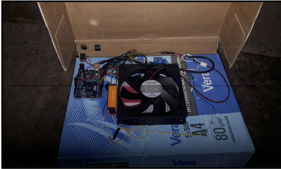
Şekil 7:Tavana yerleştirilen mini fan, gizli elektronik malzeme ve kablo tesisatı
